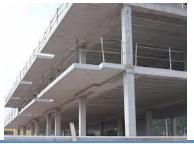
Entramado de pilares y vigas en hormigón armado como elementos resistentes, forjados unidireccionales de viguetas prefabricadas de hormigón y bovedilla cerámica y/o hormigón, muro de carga de 1pie de espesor de ladrillo cerámico.
