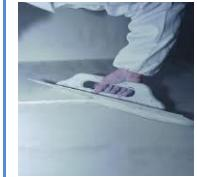
En sótano - enfoscado de mortero de cemento maestreado. Techos en yesos. Vivienda yesos maestreados en paramentos verticales con terminación meca fino, falso techo de Pladur en zonas con instalaciones.
